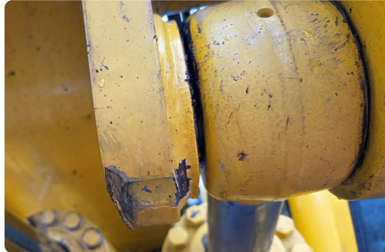
Bei zu viel Spiel am Bolzen des Auslegers kann dieser sich bis zum Hauptausleger verwinden und diesen beschädigen
