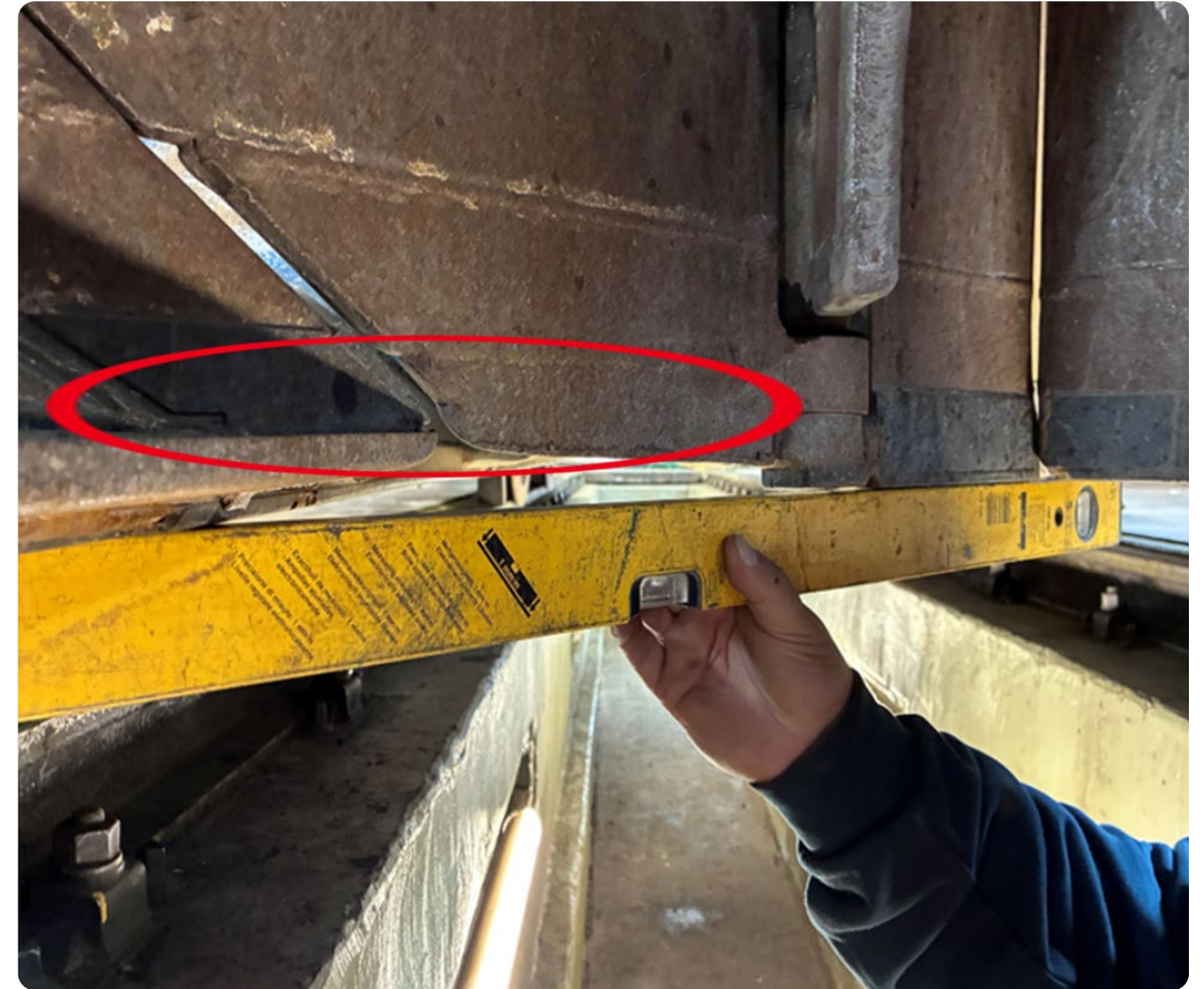
© DB InfraGO Maschinenpool und Fahrwegmessung
