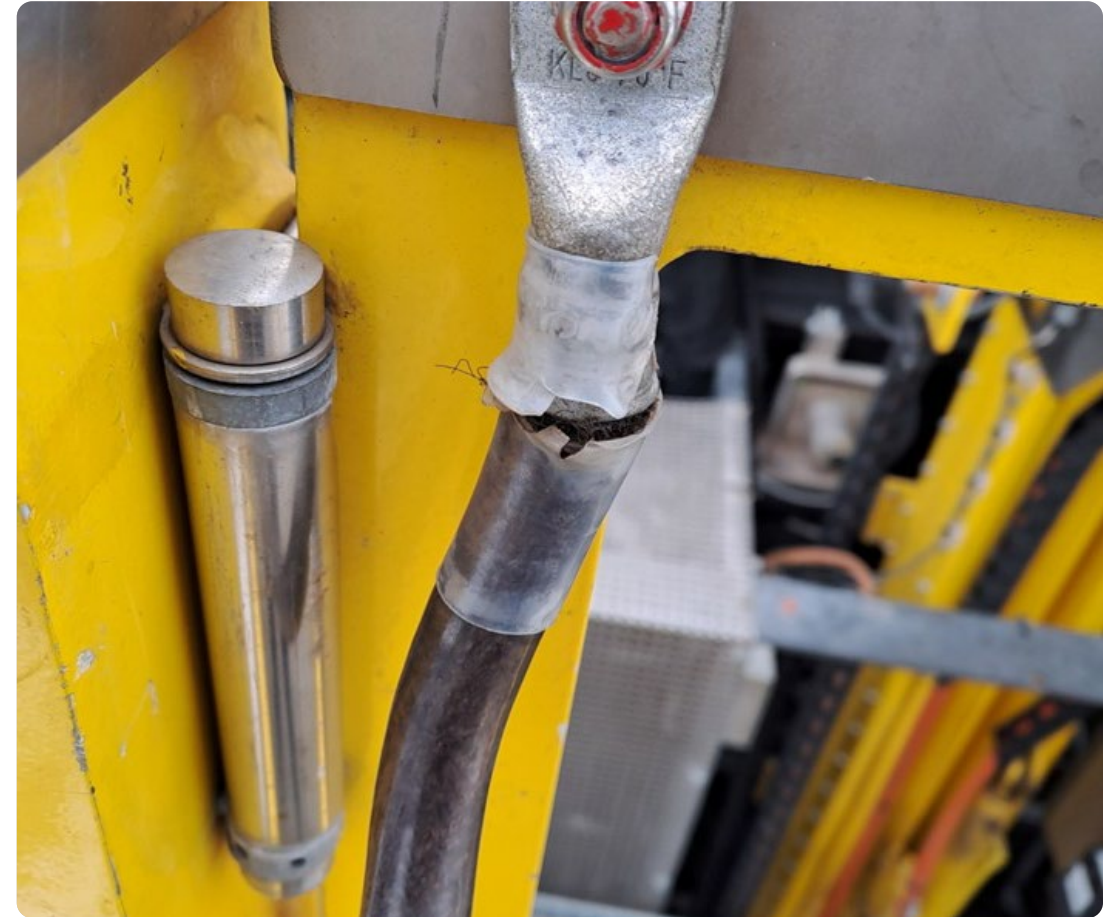
© DB InfraGO Maschinenpool und Fahrwegmessung
