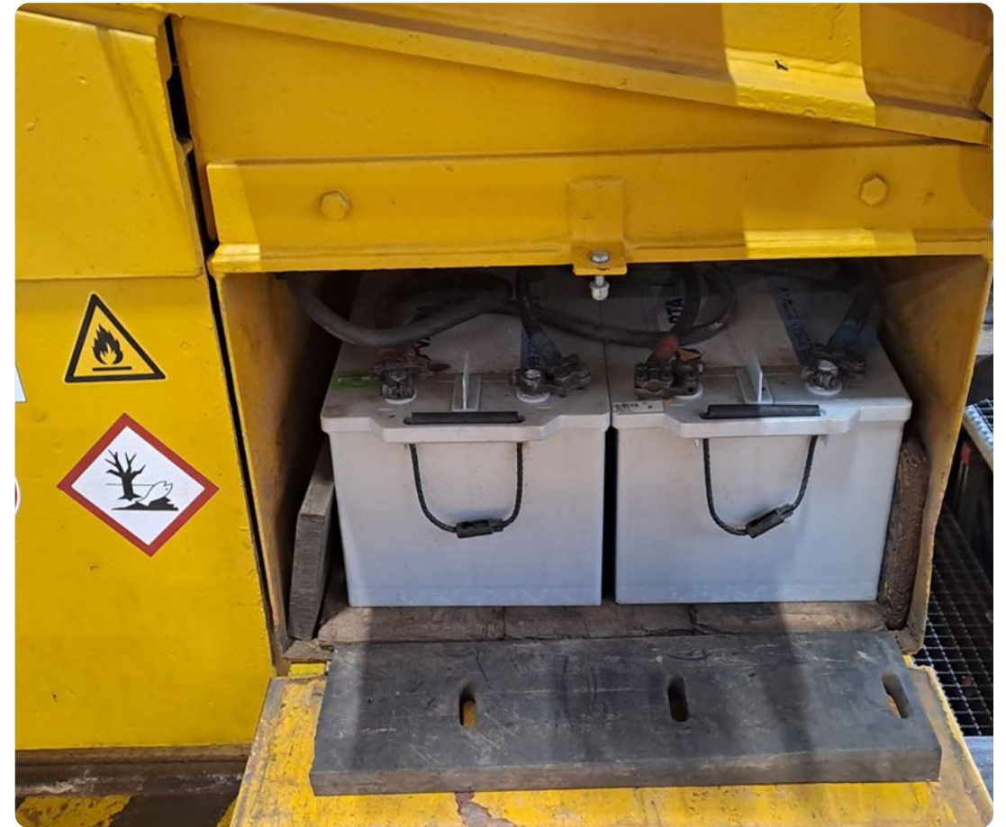
© DB InfraGO Maschinenpool und Fahrwegmessung
