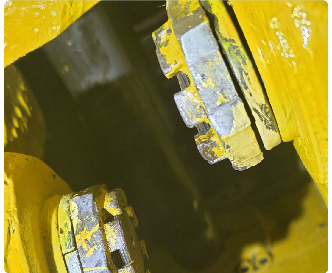
© DB InfraGO Maschinenpool und Fahrwegmessung
