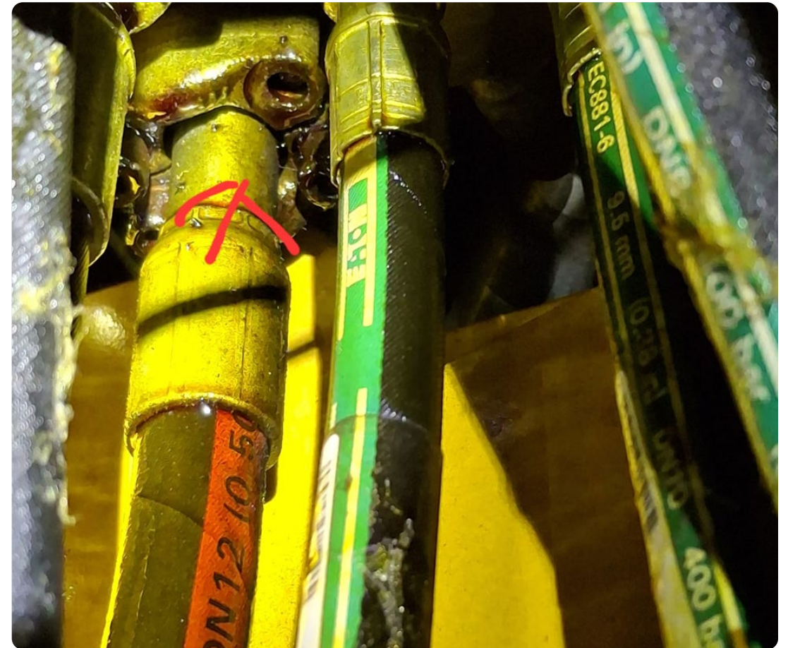
© DB InfraGO Maschinenpool und Fahrwegmessung
