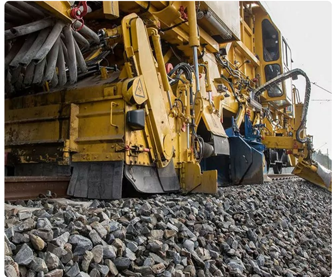
© DB InfraGO Maschinenpool und Fahrwegmessung
