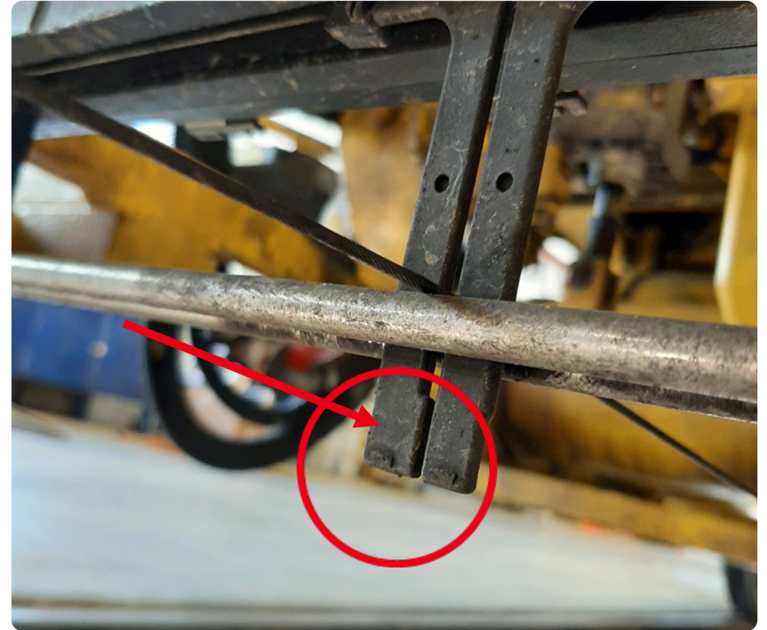
© DB InfraGO Maschinenpool und Fahrwegmessung
