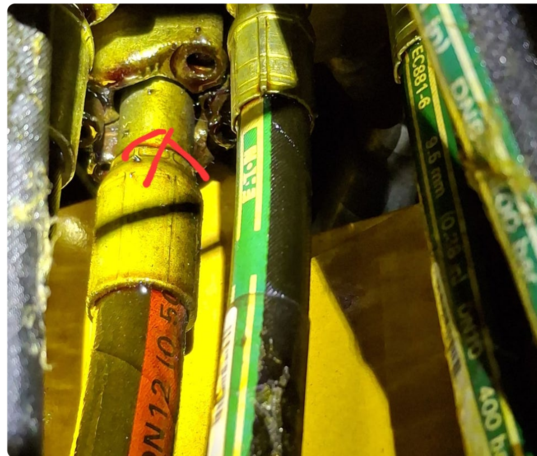
© DB InfraGO Maschinenpool und Fahrwegmessung
