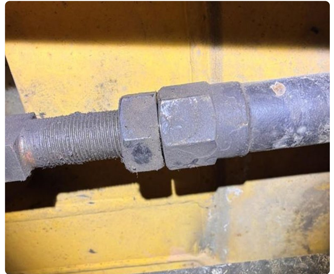
© DB InfraGO Maschinenpool und Fahrwegmessung
