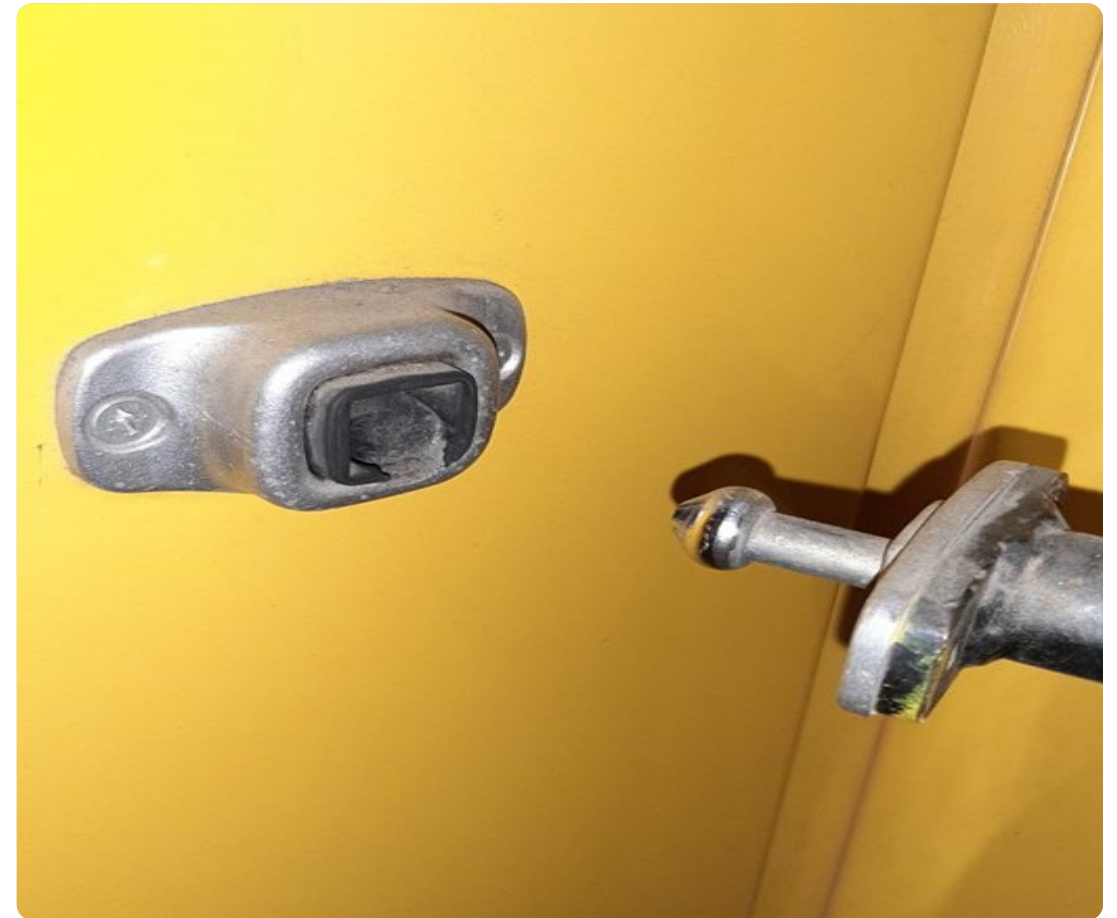
© DB InfraGO Maschinenpool und Fahrwegmessung
