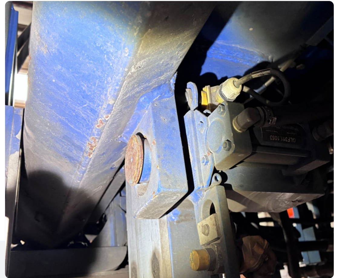
© DB InfraGO Maschinenpool und Fahrwegmessung
