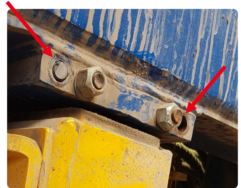
© DB InfraGO Maschinenpool und Fahrwegmessung
