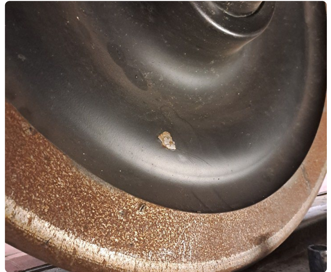
© DB InfraGO Maschinenpool und Fahrwegmessung
