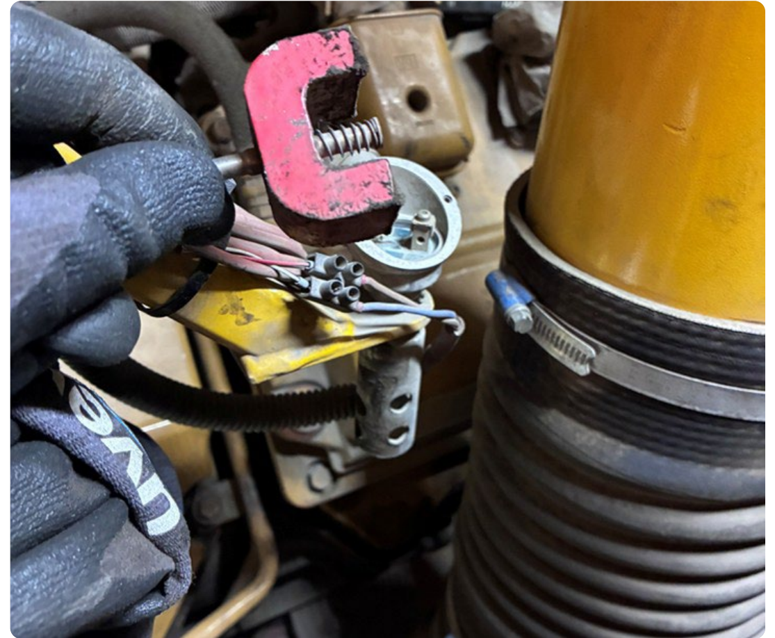
© DB InfraGO Maschinenpool und Fahrwegmessung
