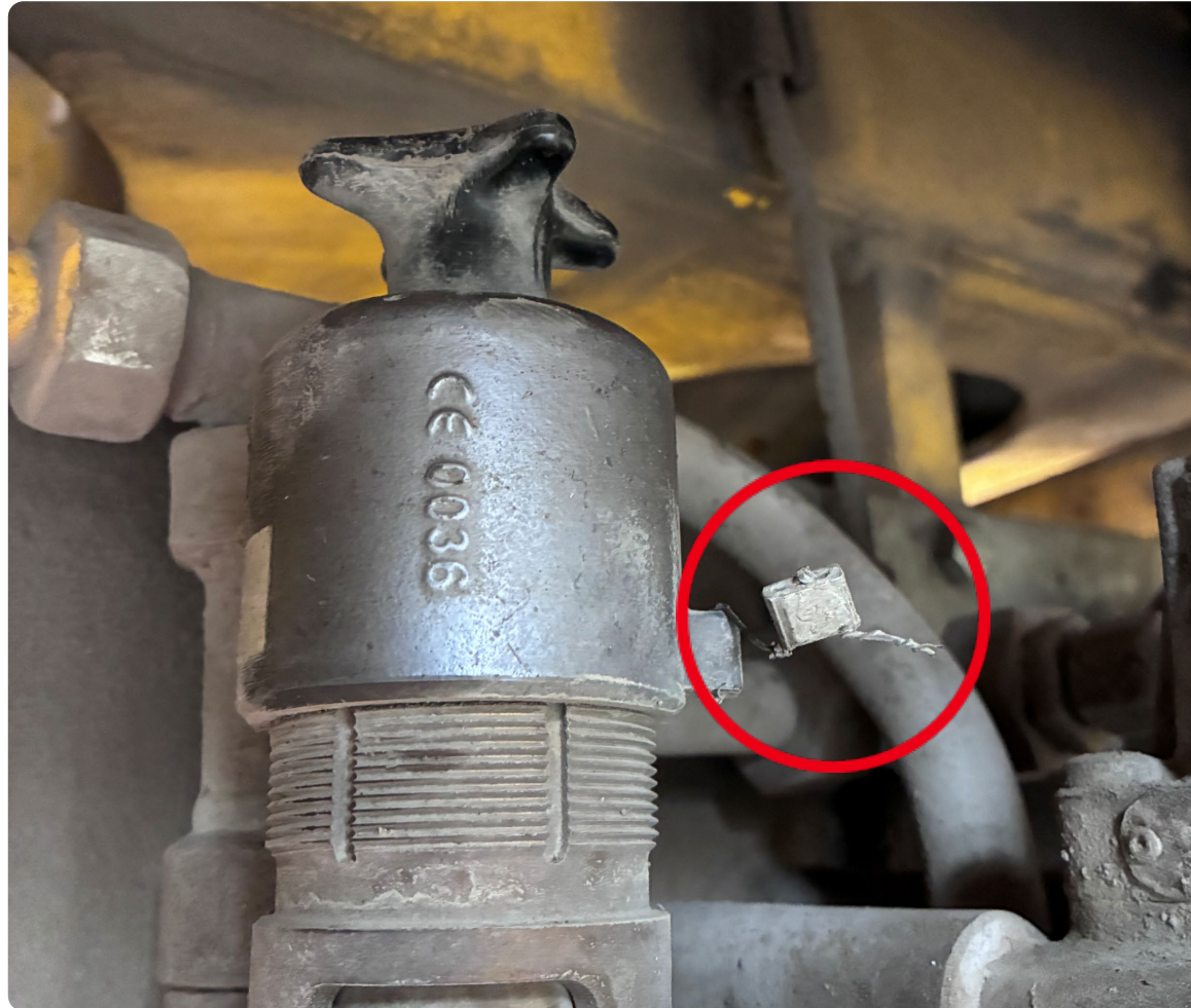
© DB InfraGO Maschinenpool und Fahrwegmessung
