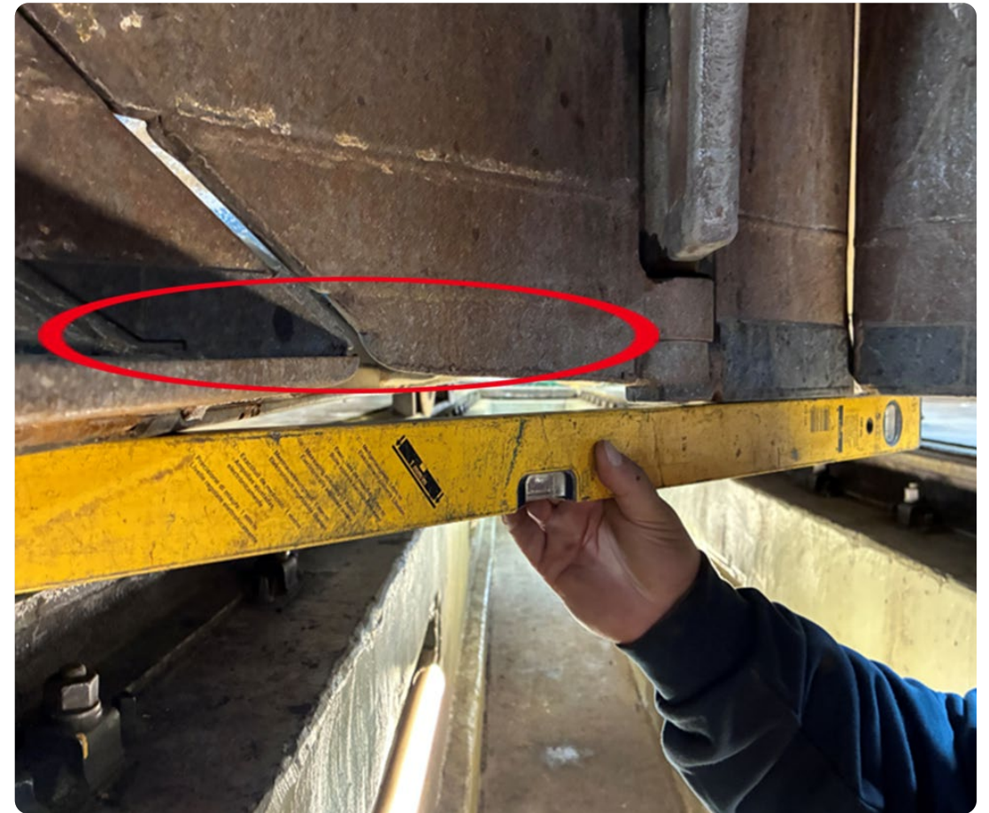
© DB InfraGO Maschinenpool und Fahrwegmessung
