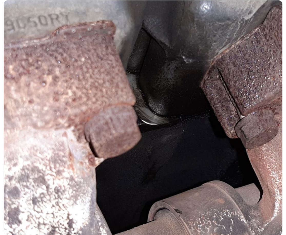
© DB InfraGO Maschinenpool und Fahrwegmessung
