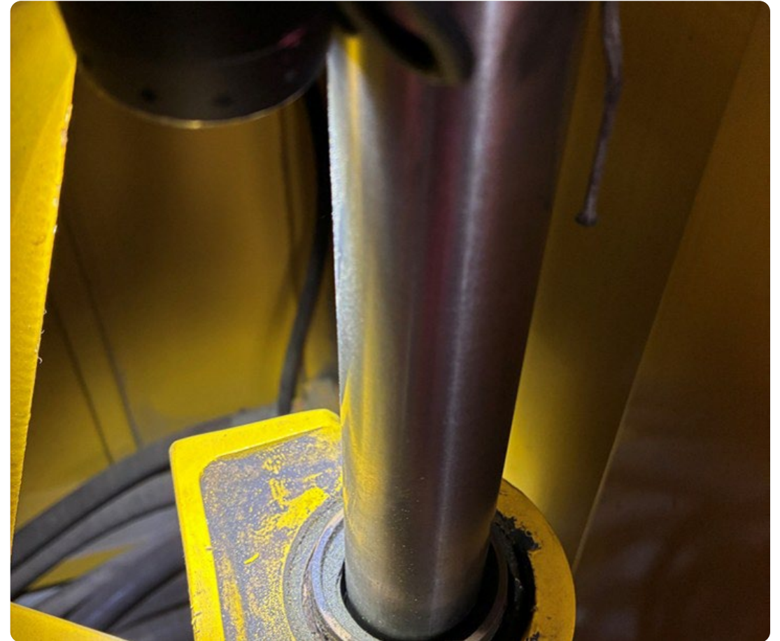
© DB InfraGO Maschinenpool und Fahrwegmessung
