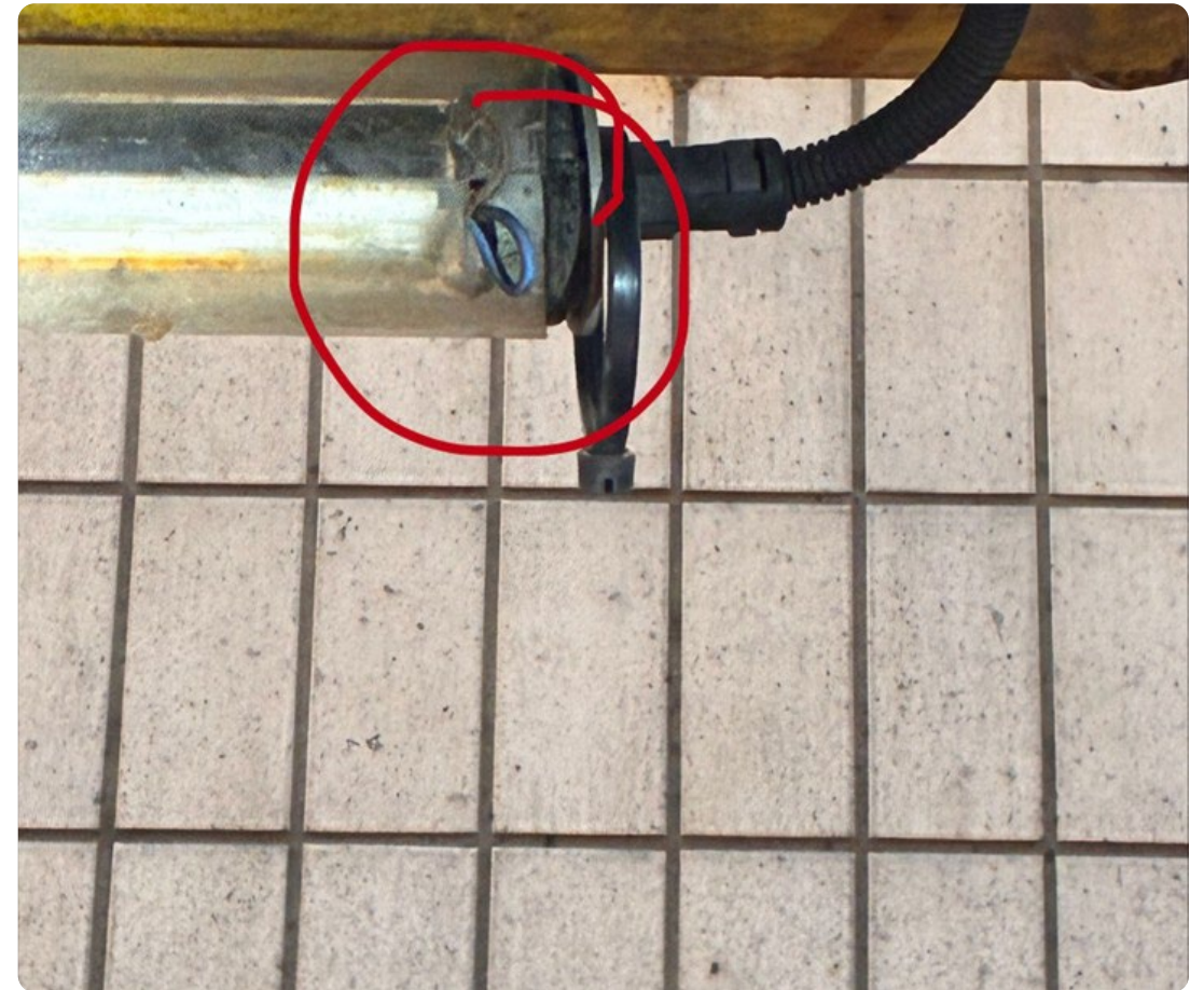
© DB InfraGO Maschinenpool und Fahrwegmessung
